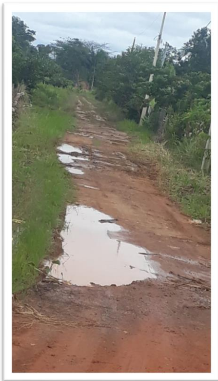
Figura 1 – Pavimentação de via pública.
