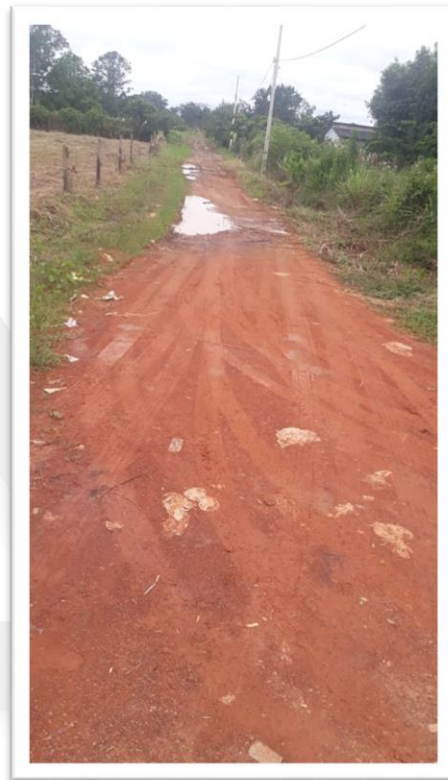
Figura 2 – Pavimentação de via pública.
