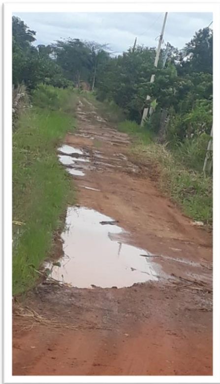
Figura 1 – Pavimentação de via pública.
