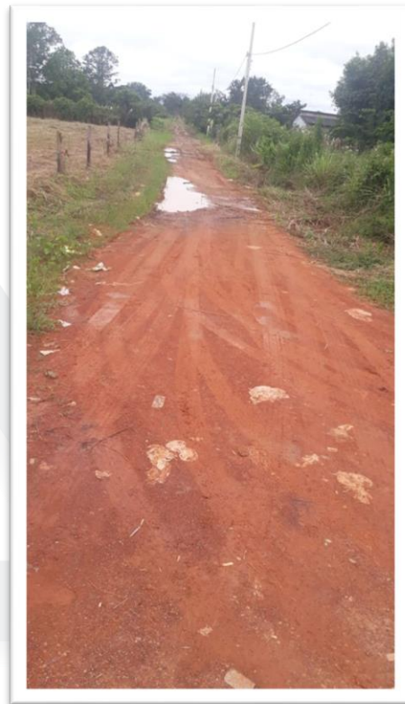
Figura 2 – Pavimentação de via pública.
