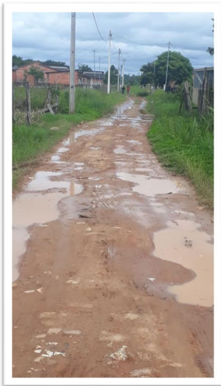
Figura 1 – Pavimentação de via pública.
