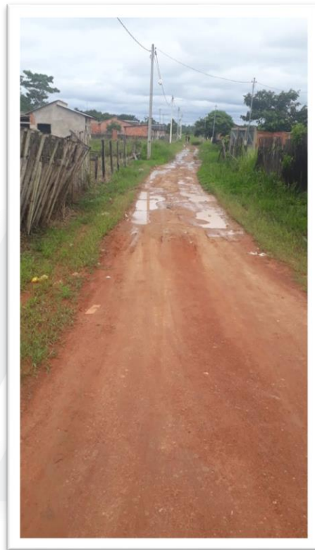
Figura 2 – Pavimentação de via pública.
