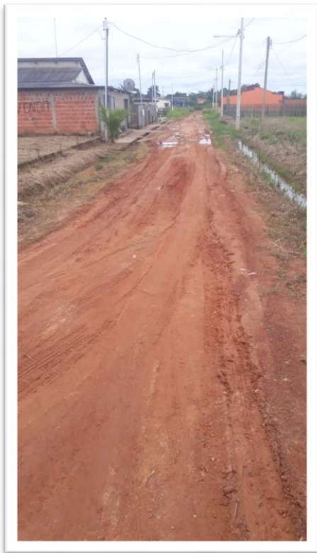
Figura 1 – Pavimentação de via pública.
