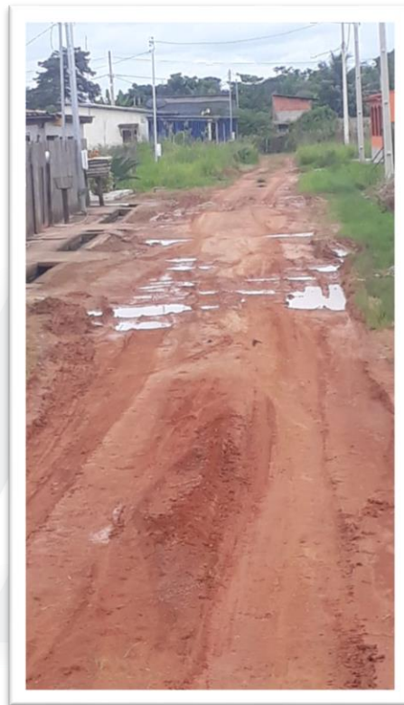
Figura 2 – Pavimentação de via pública.
