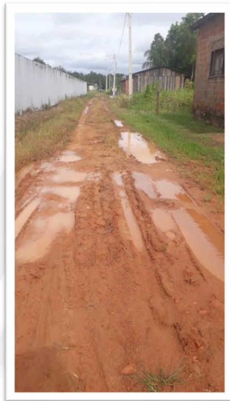
Figura 2 – Pavimentação de via pública.
