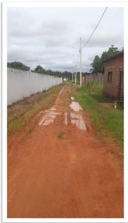
Figura 1 – Pavimentação de via pública.
