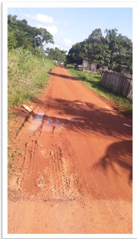
Figura 1 – Pavimentação de via pública.
