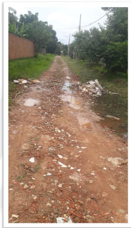
Figura 2 – Pavimentação de via pública.
