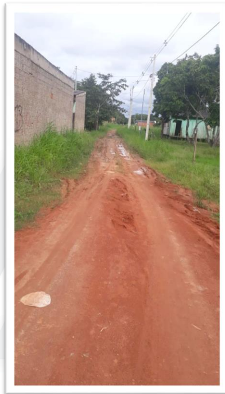
Figura 2 – Pavimentação de via pública.
