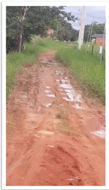
Figura 1 – Pavimentação de via pública.
