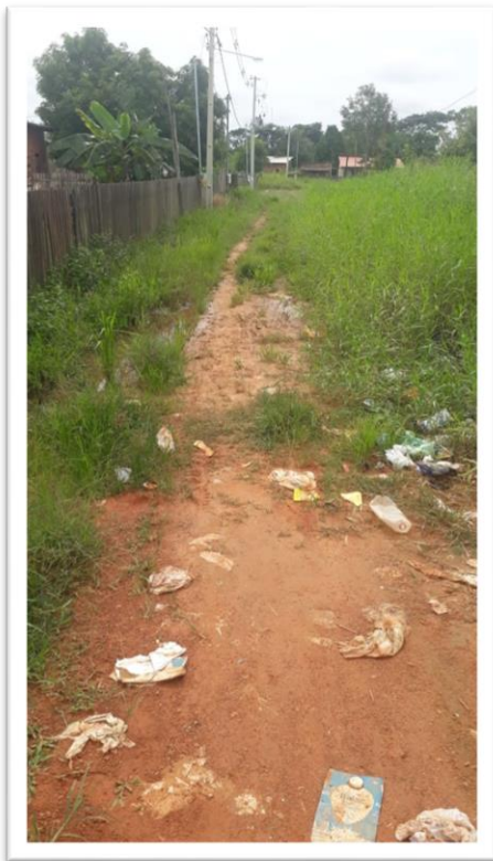
Figura 1 – Pavimentação de via pública.
