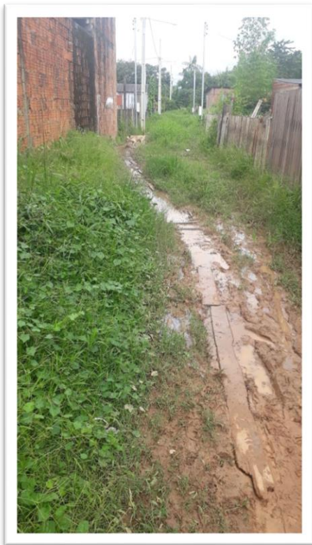
Figura 1 – Pavimentação de via pública.
