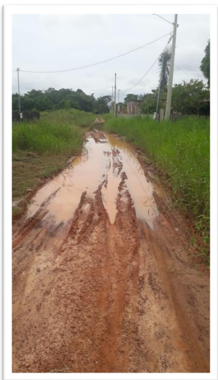
Figura 1 – Pavimentação de via pública.
