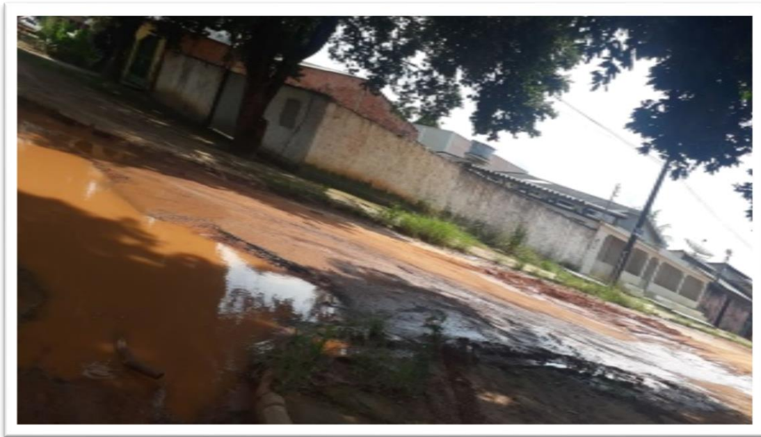
Figura 1 – Pavimentação de via pública.
