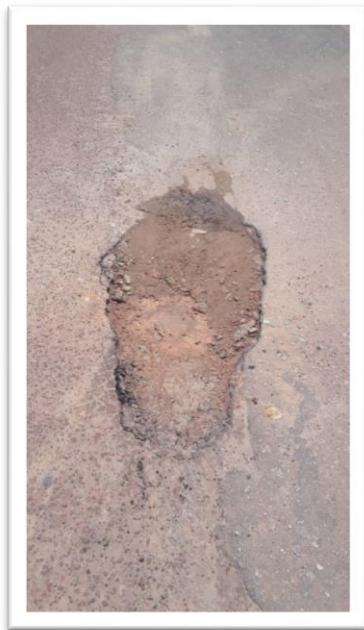
Figura 1 – Pavimentação de via pública.
