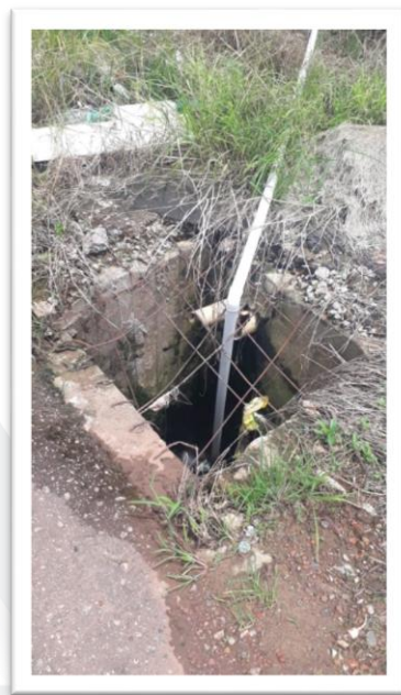
Figura 2 – Tapa de bueiro em via pública.
