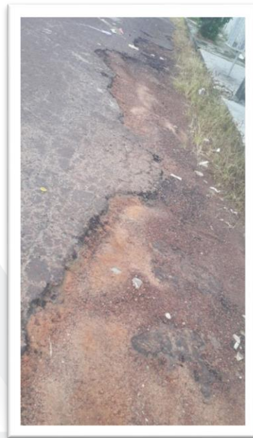
Figura 2 – Pavimentação de via pública.
