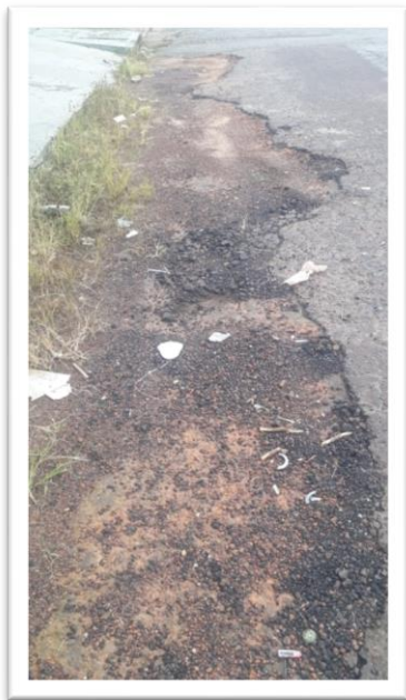
Figura 1 – Pavimentação de via pública.
