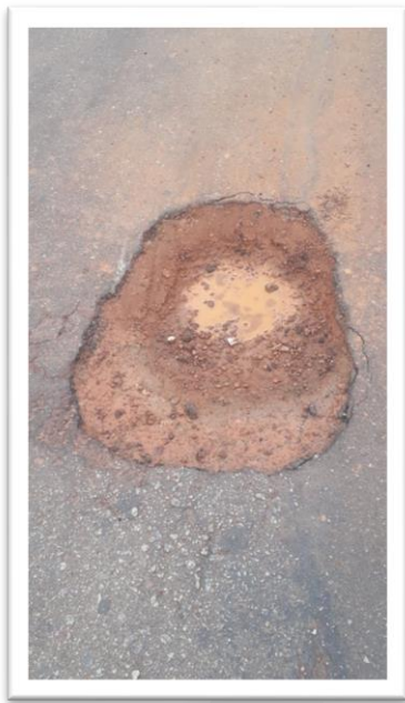
Figura 1 – Pavimentação de via pública.
