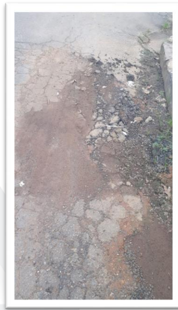
Figura 2 – Pavimentação de via pública.
