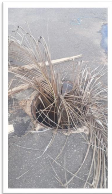
Figura 1 – Tampa de bueiro em via pública.
