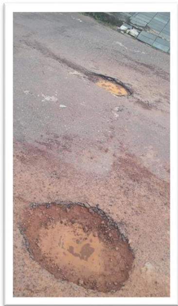
Figura 1 – Pavimentação de via pública.
