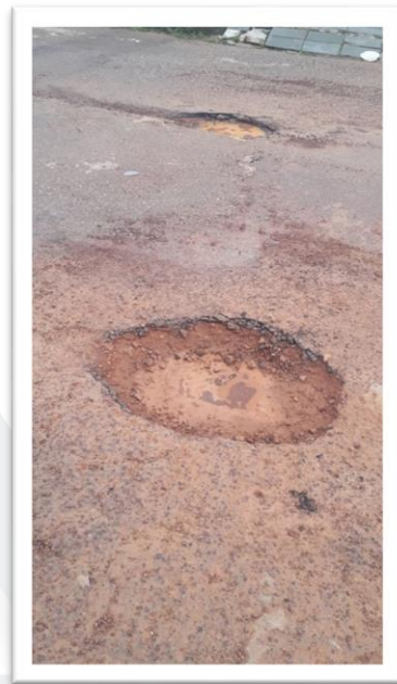
Figura 2 – Pavimentação de via pública.
