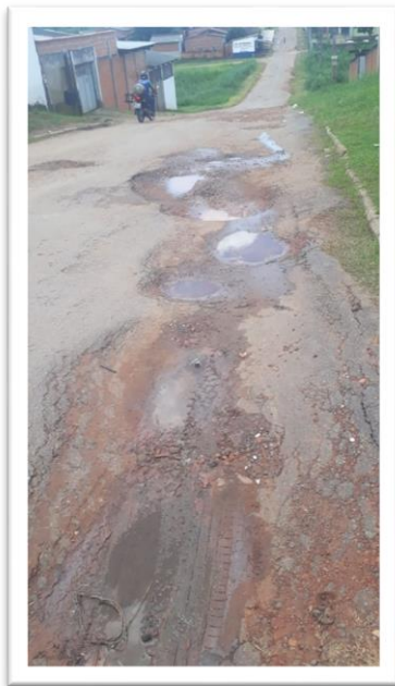
Figura 1 – Pavimentação de via pública.
