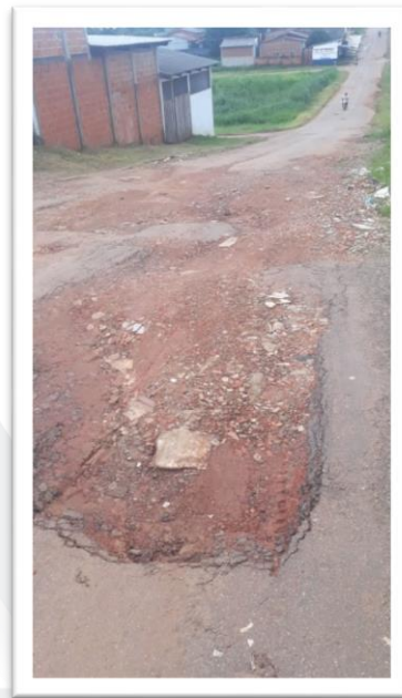
Figura 2 – Pavimentação de via pública.
