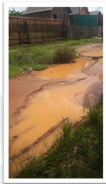
Figura 2 – Pavimentação de via pública.
