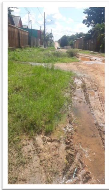
Figura 1 – Pavimentação de via pública.
