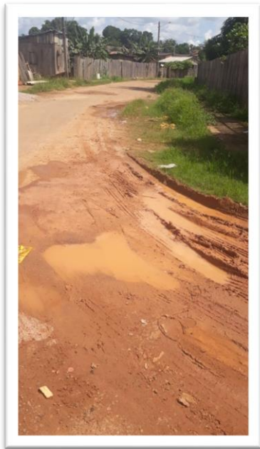
Figura 1 – Pavimentação de via pública.
