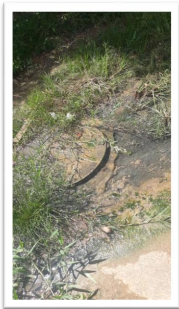
Figura 1 – Desobstrução de bueiro em via pública.
