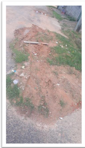
Figura 1 – Pavimentação de via pública.
