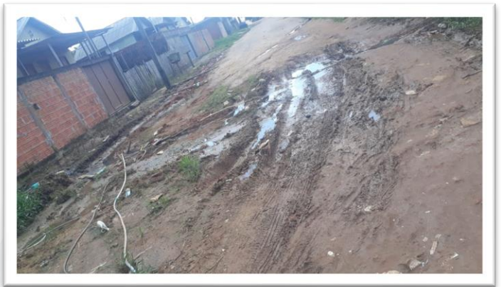
Figura 2 – Pavimentação de via pública.
