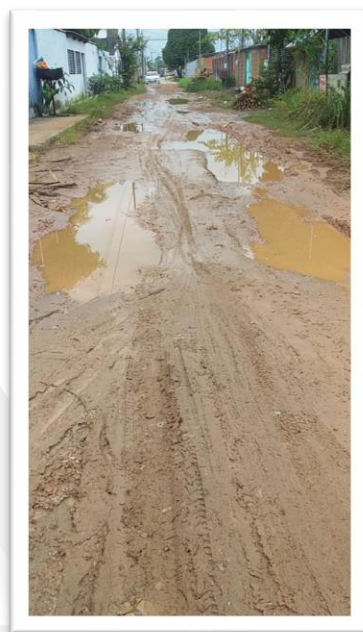
Figura 2 – Pavimentação de via pública.
