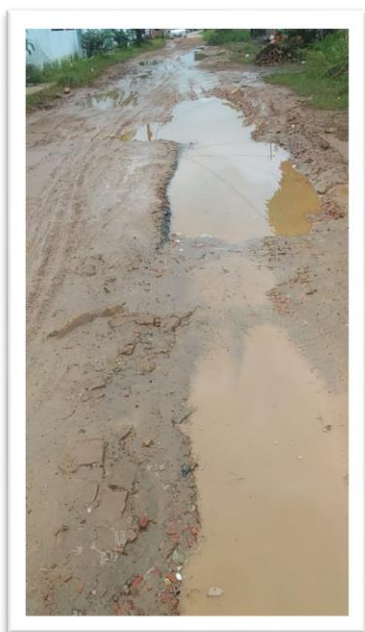
Figura 1 – Pavimentação de via pública.
