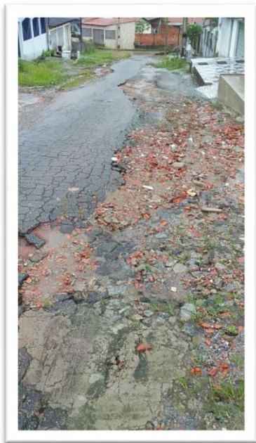
Figura 1 – Pavimentação de via pública.
