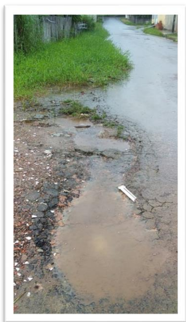
Figura 1 – Pavimentação de via pública.
