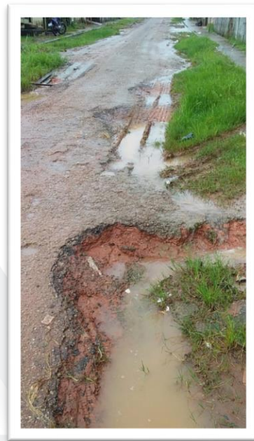
Figura 2 – Pavimentação de via pública.
