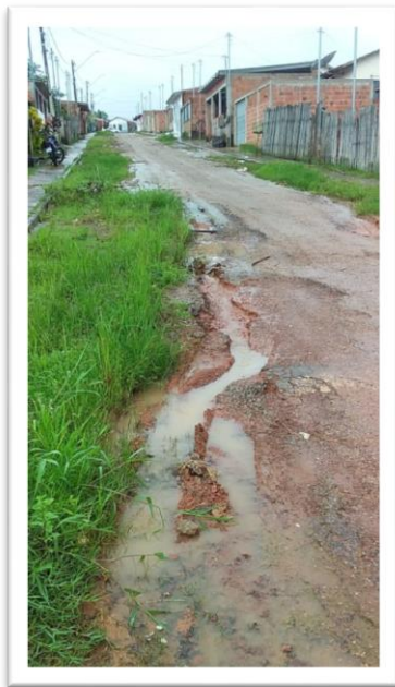
Figura 1 – Pavimentação de via pública.
