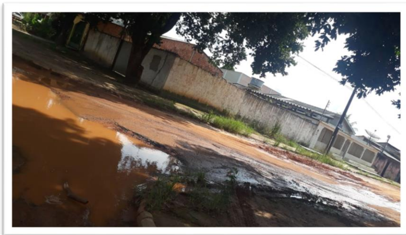
Figura 1 – Pavimentação de via pública.
