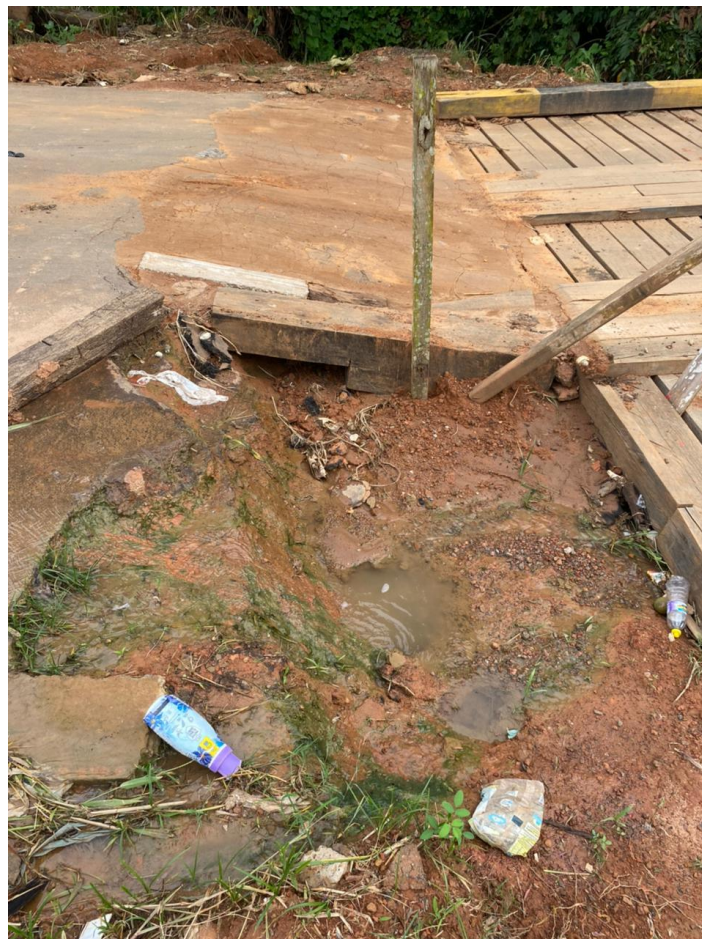
Figura 3 – Cabeceira da Ponte sobre o Igarapé Judia.
