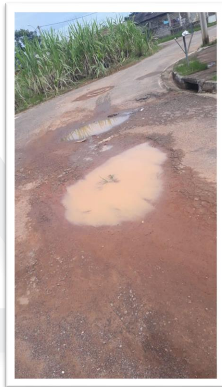
Figura 2 – Pavimentação de via pública.
