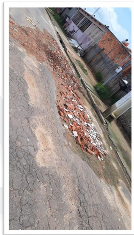
Figura 2 – Pavimentação de via pública.
