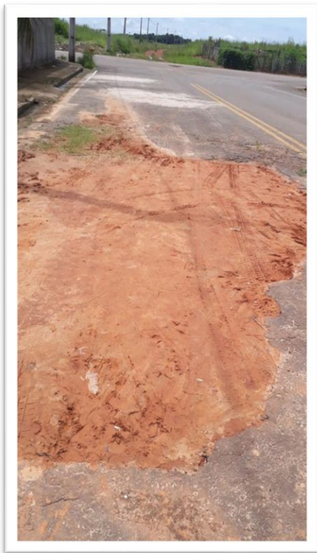
Figura 1 – Pavimentação de via pública.
