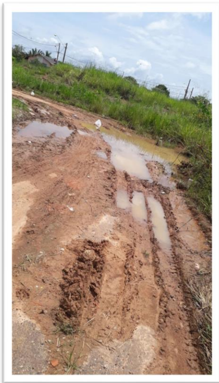
Figura 1 – Pavimentação de via pública.
