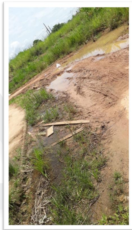
Figura 2 – Pavimentação de via pública.
