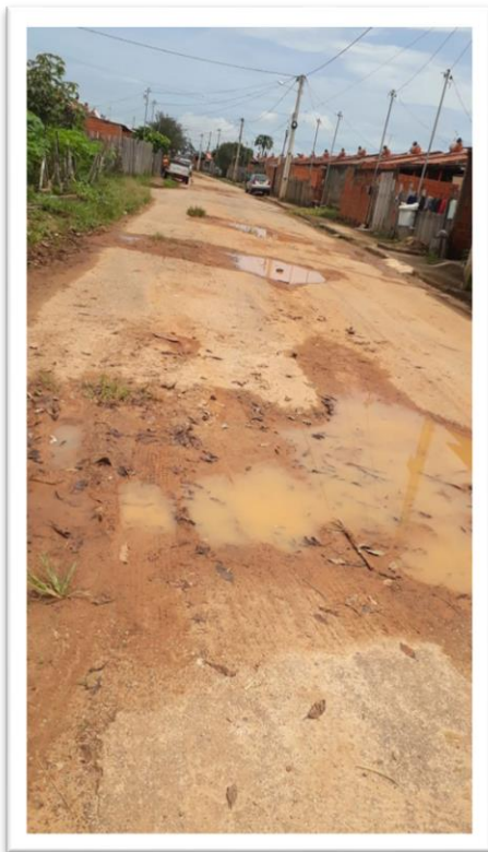
Figura 1 – Pavimentação de via pública.
