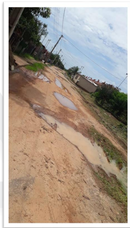
Figura 2 – Pavimentação de via pública.
