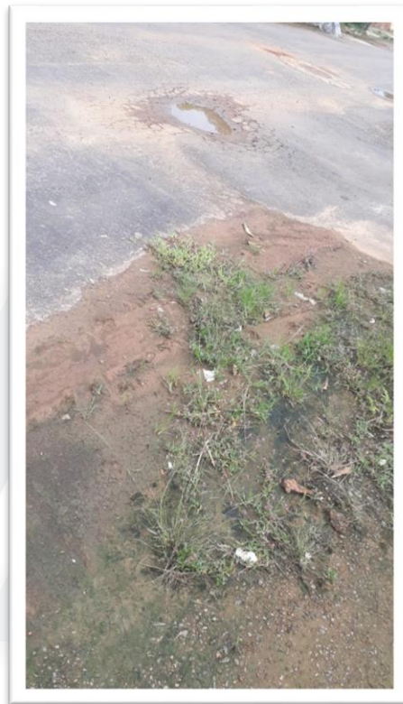
Figura 2 – Pavimentação de via pública.
