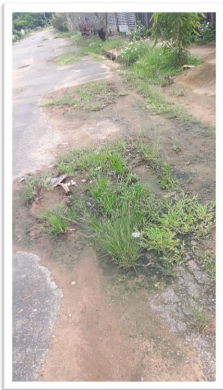
Figura 1 – Pavimentação de via pública.
