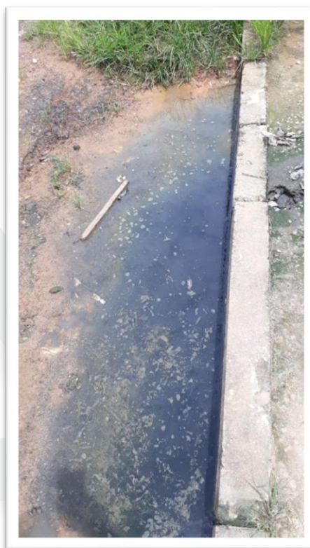
Figura 2 – Desobstrução de bueiro em via pública.
