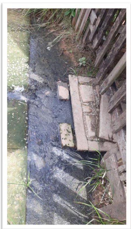
Figura 1 – Desobstrução de bueiro em via pública.
