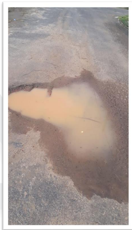
Figura 2 – Pavimentação de via pública.
