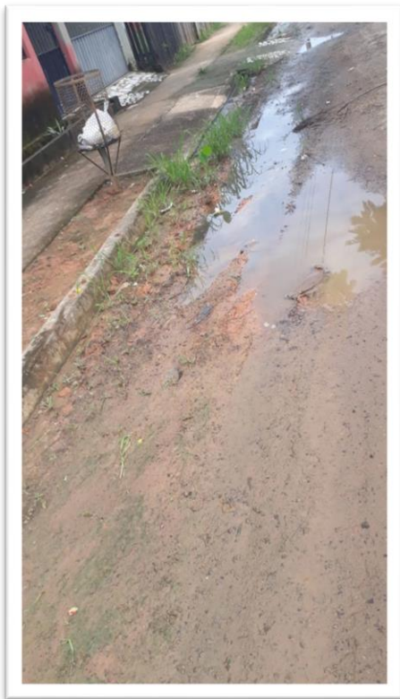
Figura 1 – Pavimentação de via pública.
