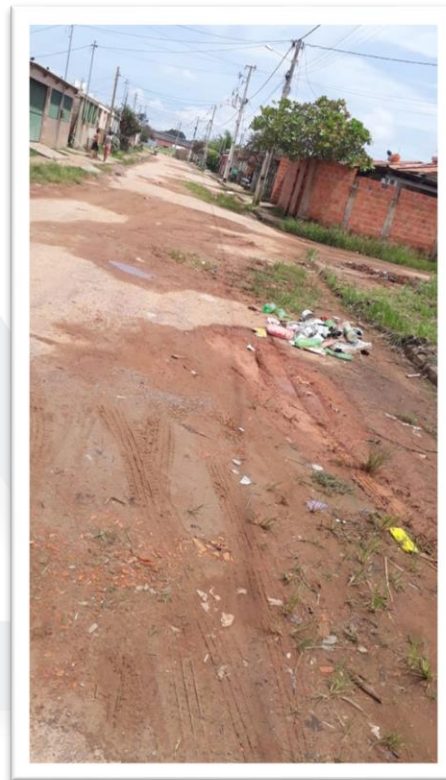
Figura 2 – Pavimentação de via pública.
