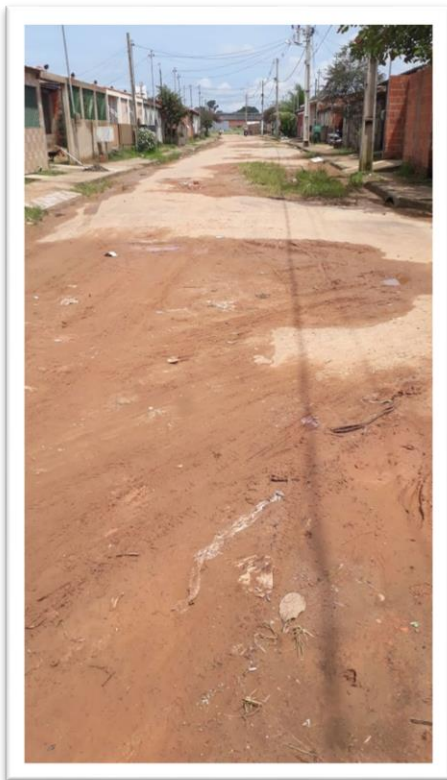
Figura 1 – Pavimentação de via pública.
