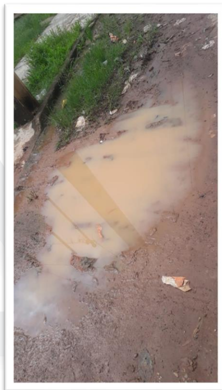
Figura 2 – Pavimentação de via pública.
