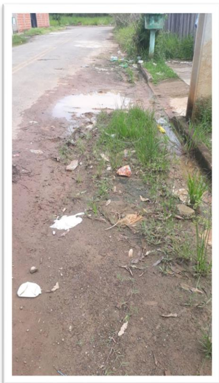
Figura 1 – Pavimentação de via pública.
