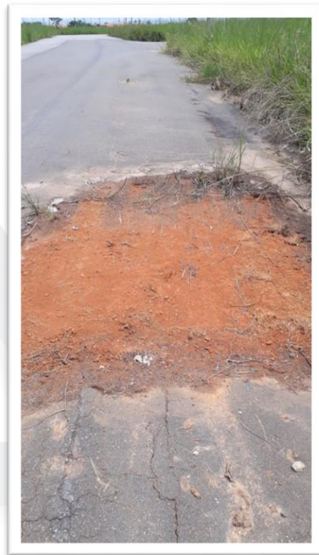
Figura 2 – Pavimentação de via pública.
