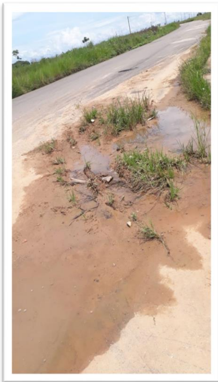
Figura 1 – Pavimentação de via pública.
