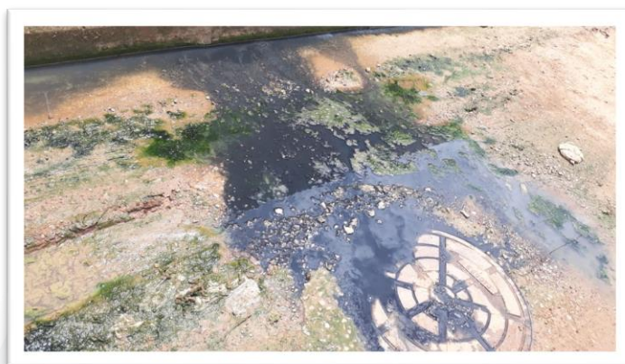
Figura 2 – Desobstrução de bueiro em via pública.
