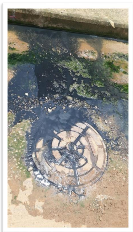
Figura 1 – Desobstrução de bueiro em via pública.
