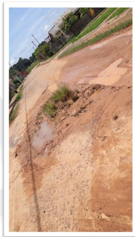
Figura 2 – Pavimentação de via pública.
