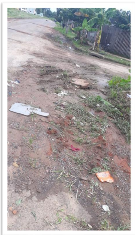
Figura 1 – Pavimentação de via pública.
