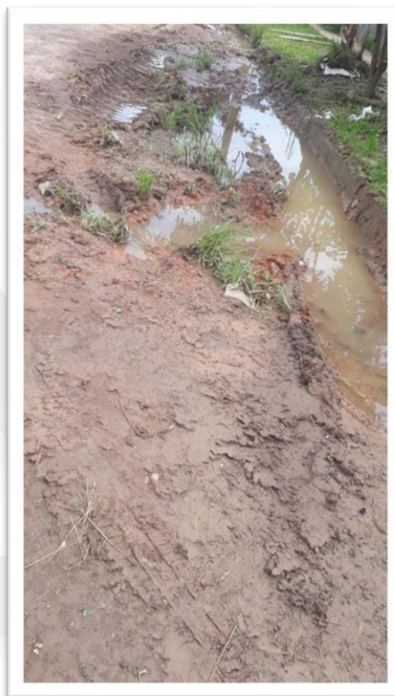
Figura 2 – Pavimentação de via pública.
