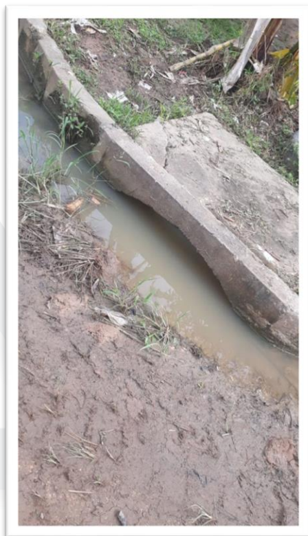
Figura 2 – Desobstrução de bueiro em via pública.
