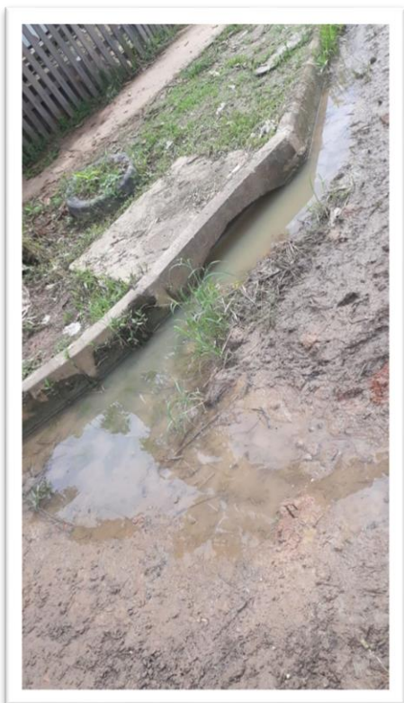
Figura 1 – Desobstrução de bueiro em via pública.
