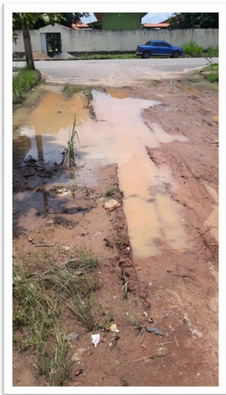
Figura 1 – Pavimentação de via pública.
