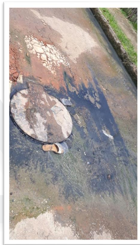
Figura 2 – Desobstrução de bueiro em via pública.
