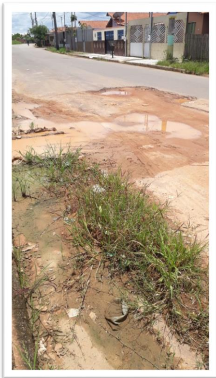
Figura 1 – Pavimentação de via pública.
