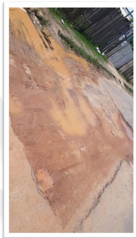
Figura 2 – Pavimentação de via pública.
