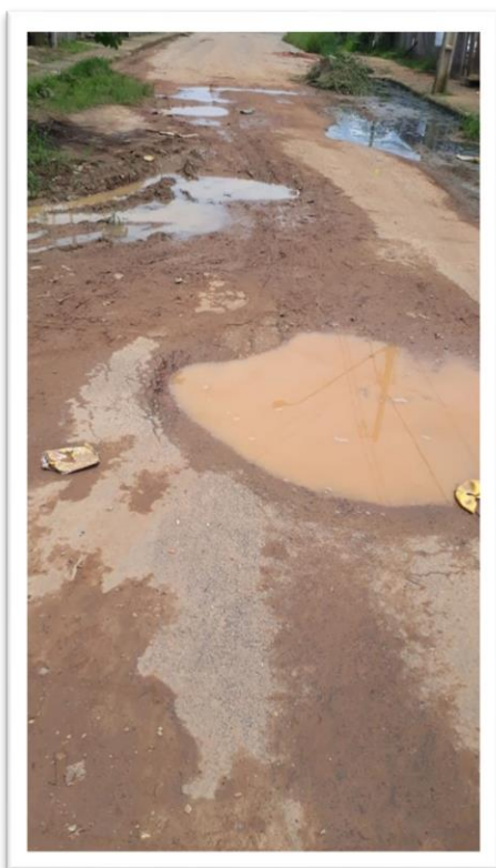
Figura 1 – Pavimentação de via pública.
