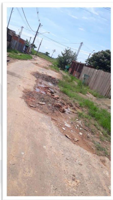
Figura 2 – Pavimentação de via pública.
