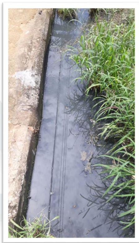
Figura 2 – Desobstrução de bueiro em via pública.
