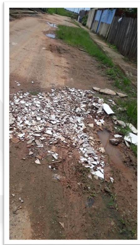
Figura 2 – Pavimentação de via pública.
